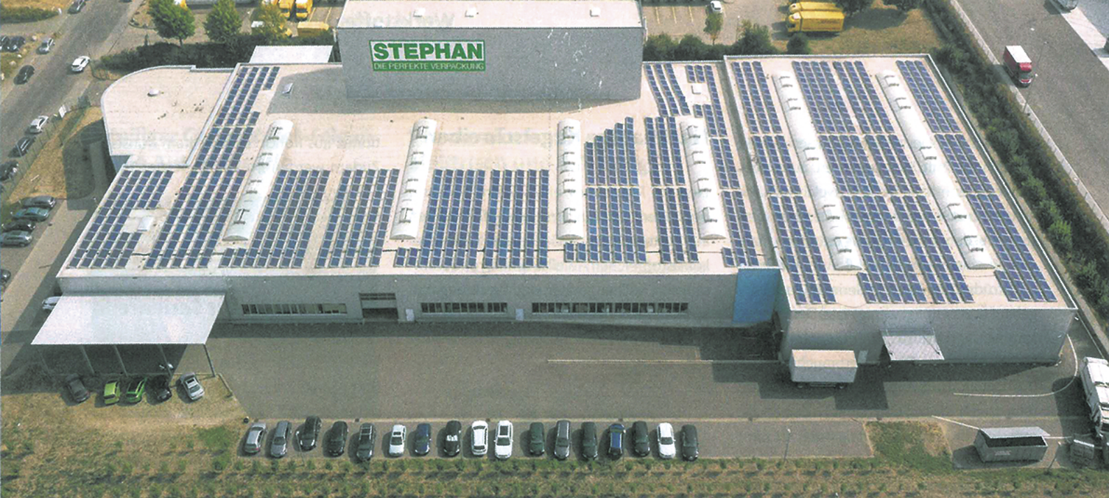
Durch die Installation einer Solaranlage auf dem Dach der Produktionshalle gelang es den Recyclingprozess CO 2 -neutral zu gestalten. (Bild: Stephan Schaumstoffe)
